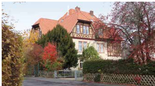
Im Landhausstil erbautes, ehemaliges Töchterheim in der Schlossteichstraße
